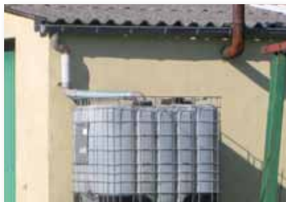
Citerne de récupération des eaux pluviales
